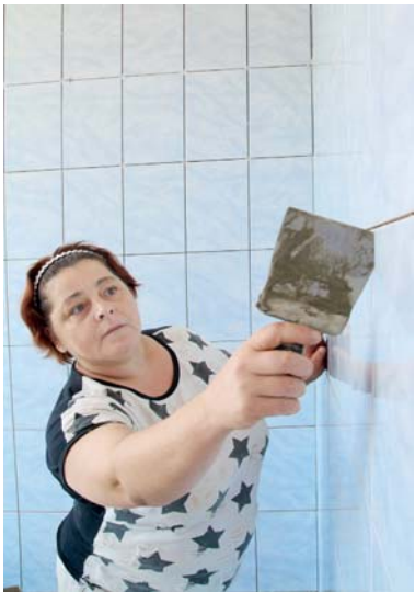
45-летнее здание школы впервые переживает капитальный ремонт
