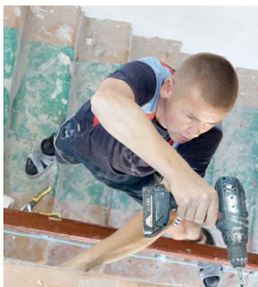
после капитального ремонта сельская школа ничем не уступит городским центрам образования.
