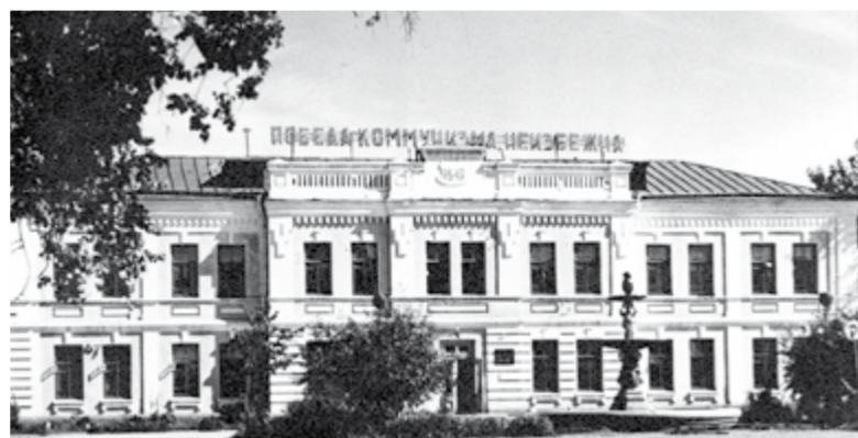
1970 год. Здание по улице Кирова в Белгороде, угол улицы Фрунзе, в котором в 1917 году размещался штаб Польского запасного полка
