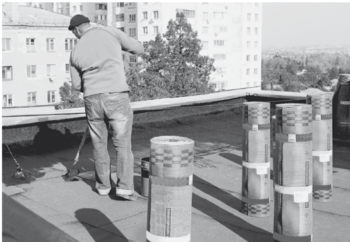
В Белгороде оперативно отремонтировали все протекавшие крыши
