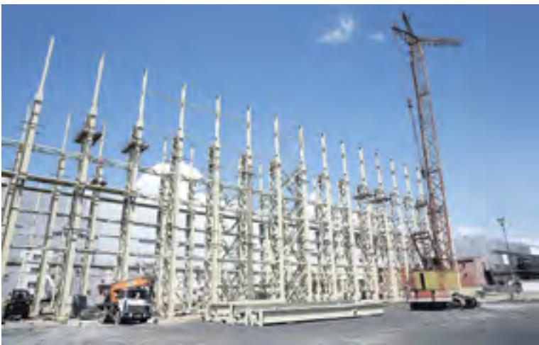
Строительство новой секции дообогащения
