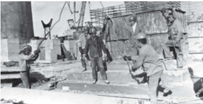
1983 год. Старый Оскол. В строительстве Оскольского электрометаллургического комбината принимают участие посланцы Народной Республики Болгарии. На снимке: бригада советских и болгарских строителей
