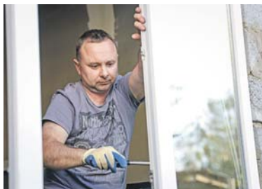
На месте разрушенного дома строители устанавливают окна
