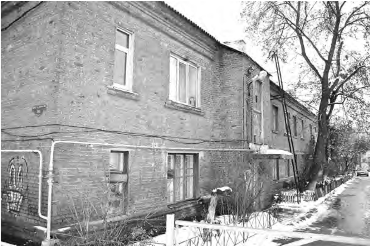
Дом, построенный в 1936 году, начал трескаться, но капитального ремонта ему ждать ещё пять лет
