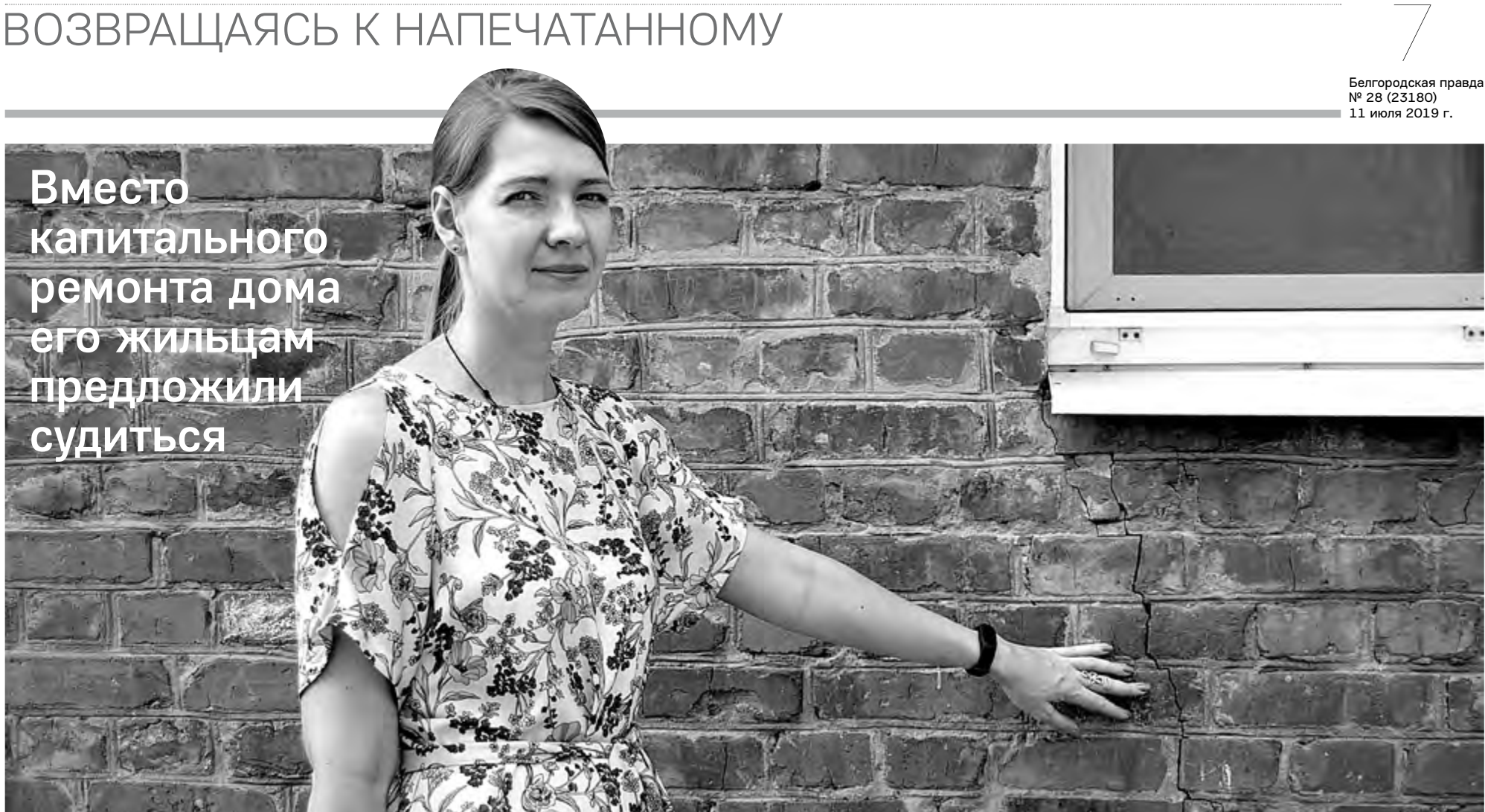
Оксана Марковская: «Зимой в трещину дуло, сквозняк был постоянный»
