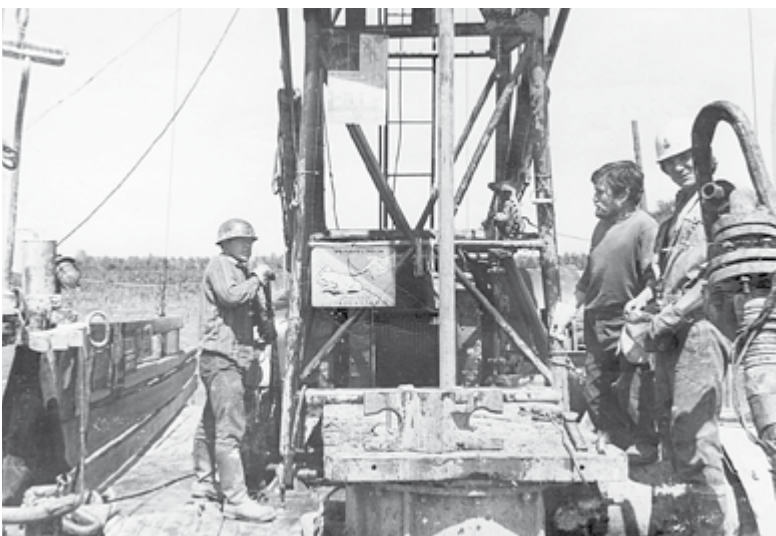
1989 год. Бурение гидронаблюдательной скважины на Яковлевском руднике
